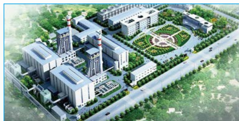
海南文昌2*460MW级燃气-蒸汽联合循环电厂机组及其辅助设备融资租赁项目
